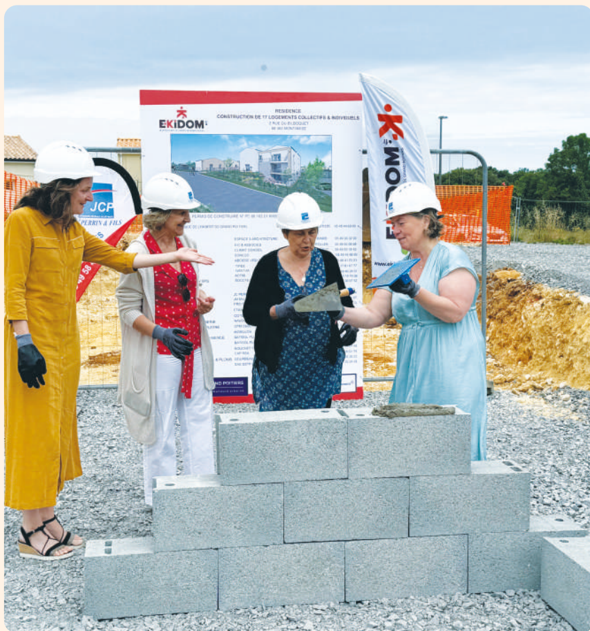
Corine SAUVAGE, Maire de Montamisé, Estelle LACOMBE, Adjointe à l'Action sociale, Elisabeth NAVEAU-DIOP, présidente d'EKIDOM et Cathie FAYE, du Territoire des Couronneries ont posé la première pierre de la future résidence « Bilboquet ».
